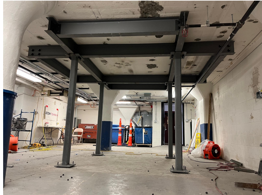
Steel frame floor reinforcement below MIT Salt Lab
